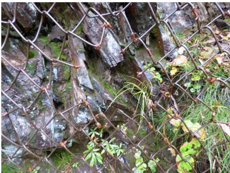
落石防止網工改修
