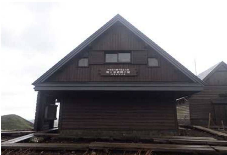
避難小屋改修 R5 完了後（南面）
