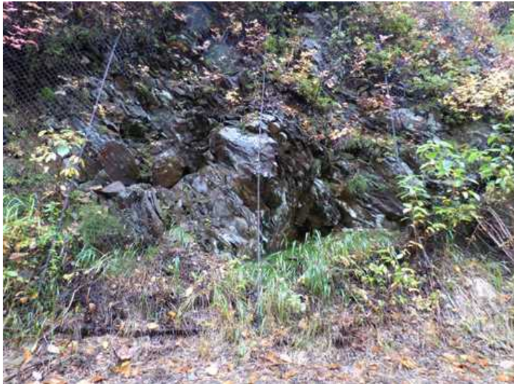
落石防止網工改修
