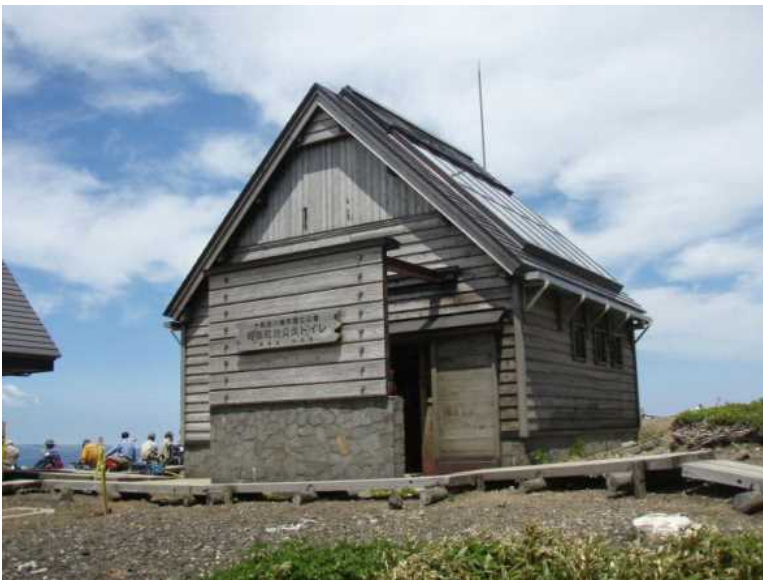
トイレ棟改修 便器の洋式化 ソーラーパネルの改修
