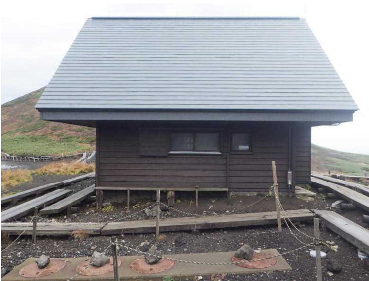
避難小屋改修 R5 完了後（東面）
