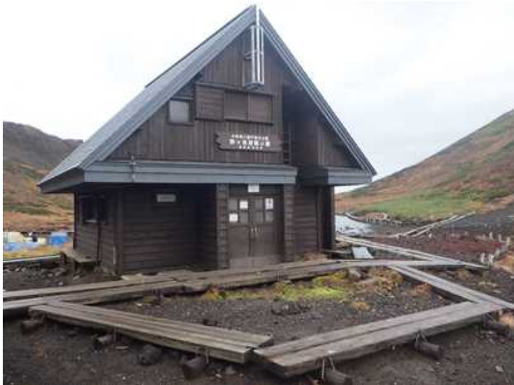
避難小屋改修 R5 完了後（北面）
