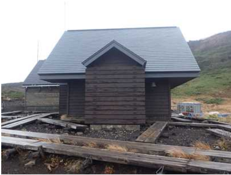
避難小屋改修 R5 完了後（西面）
