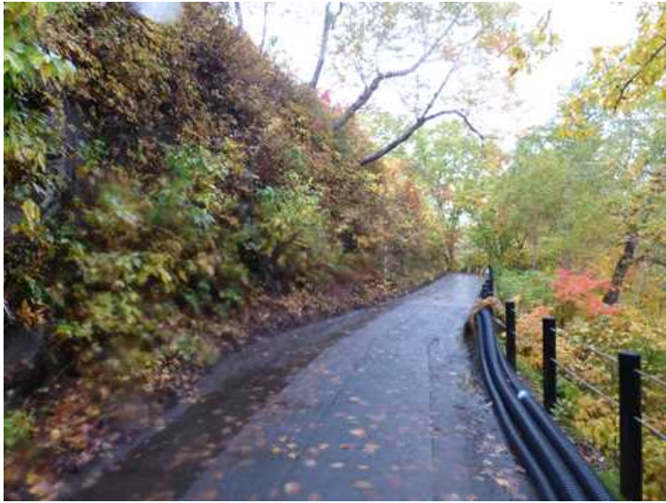
落石防止網工改修
